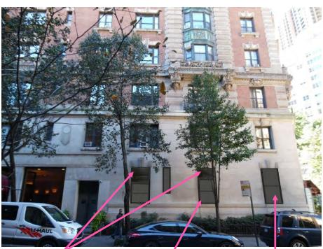
MECHANICAL SHUTTER/LOUVER PAINT TO MATCH ADJACENT FINISH KAWNEER: ALUMINUM FINISH #29 BLACK AVERY: BLACK SUPERCAST A9090-O
