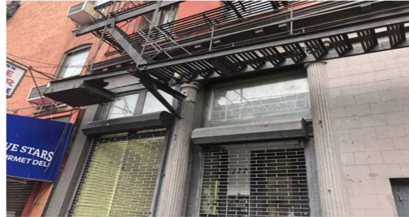
02 PHOTO OF EXISTING STOREFRONT N.T.S.
