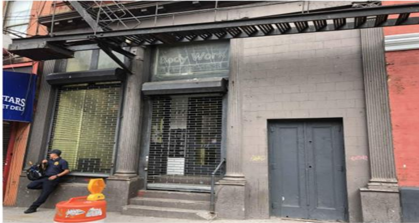
01 PHOTO OF EXISTING STOREFRONT N.T.S.
