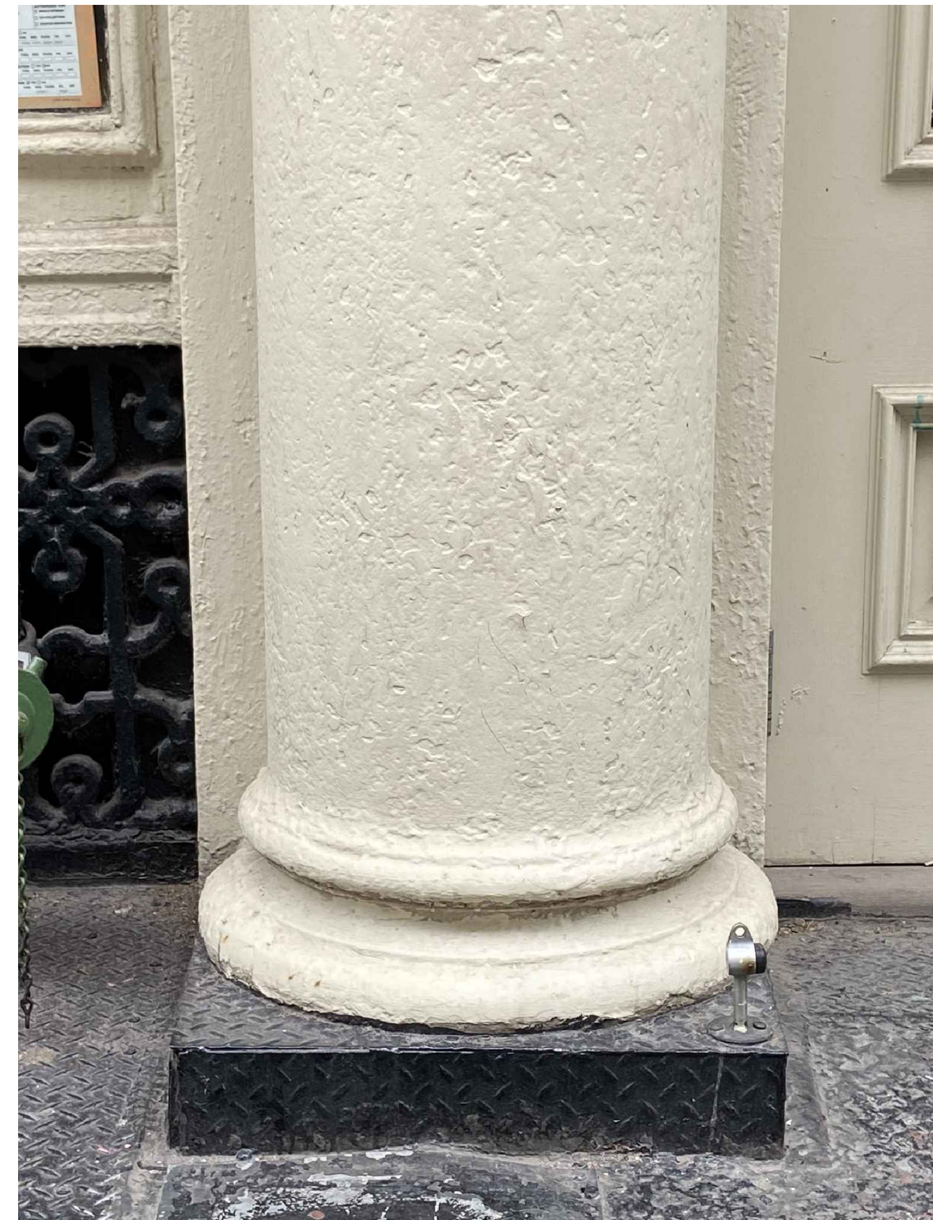
6 CAST IRON COLUMN 2 BASE CLOSE UP A-901 SCALE: N.T.S.
