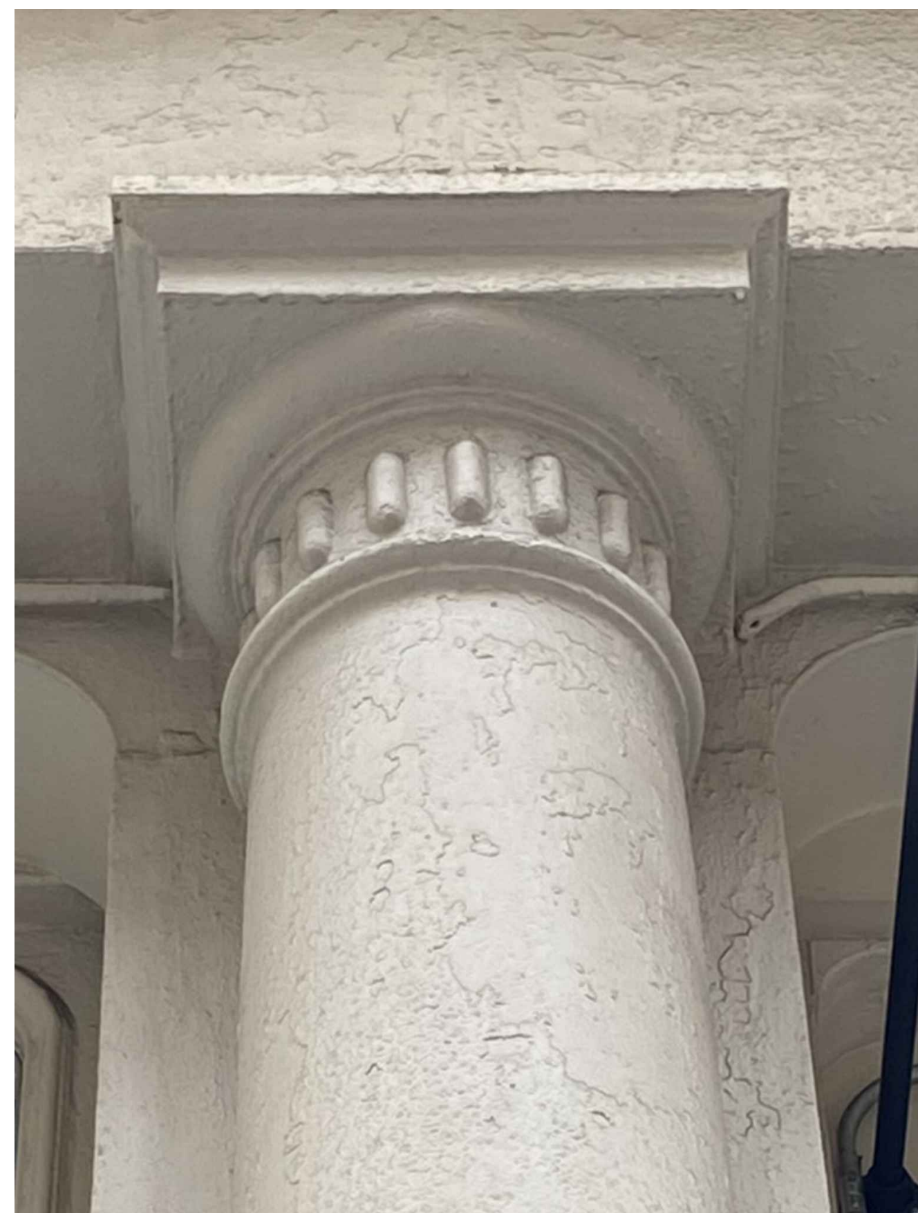
8 CAST IRON COLUMN 2 CAPITAL CLOSE UP A-901 SCALE: N.T.S.
