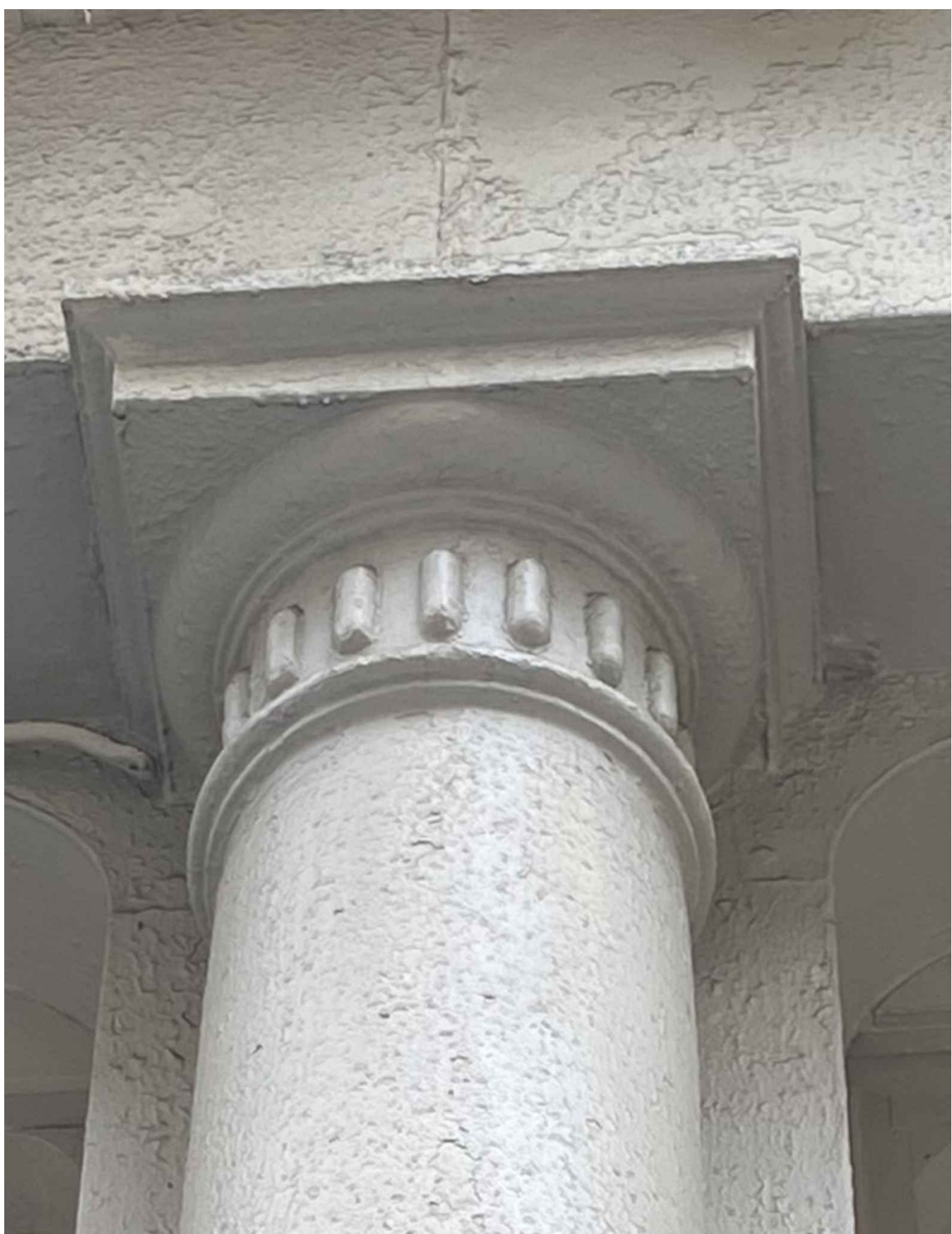
4 CAST IRON COLUMN 3 CAPITAL CLOSE UP A-902 SCALE: N.T.S.
