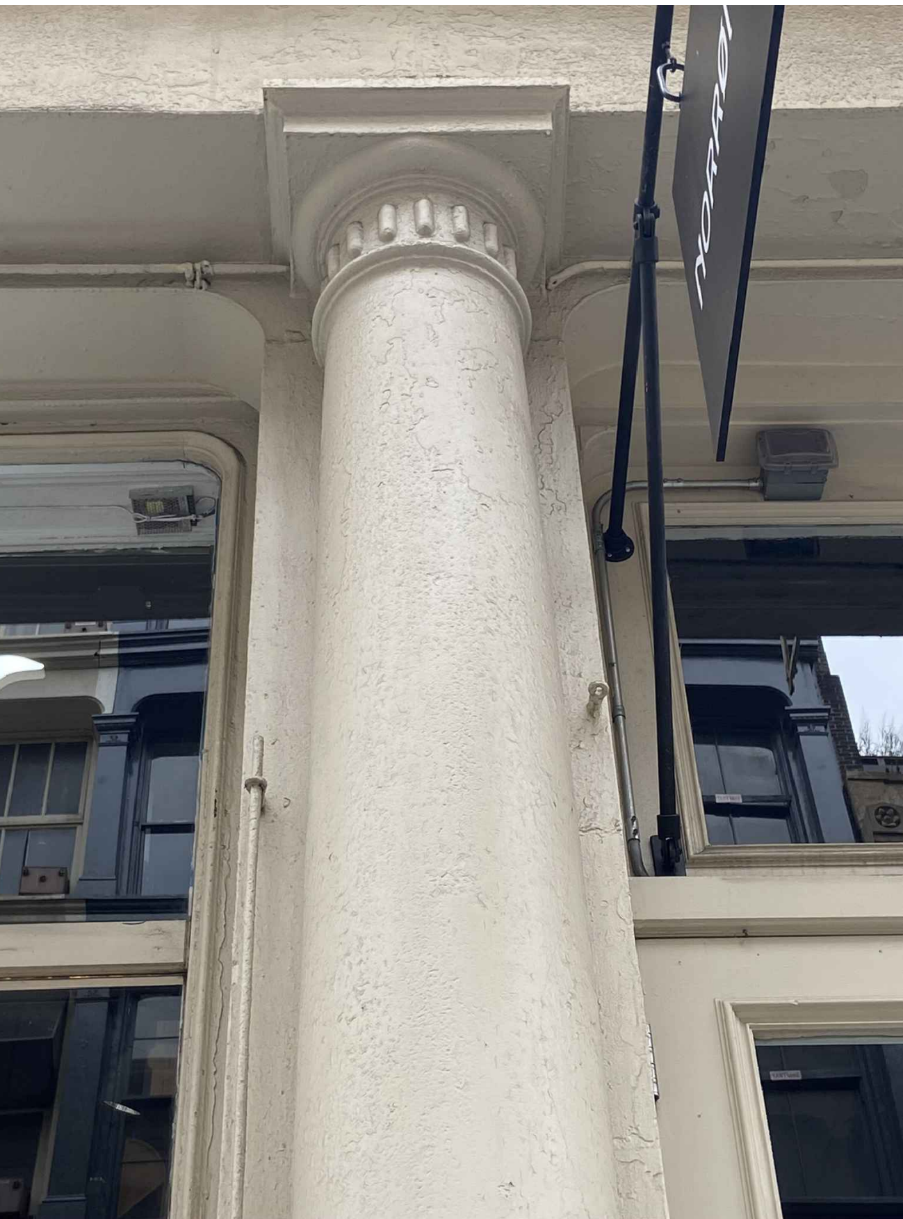
7 CAST IRON COLUMN 2 SHAFT CLOSE UP A-901 SCALE: N.T.S.
