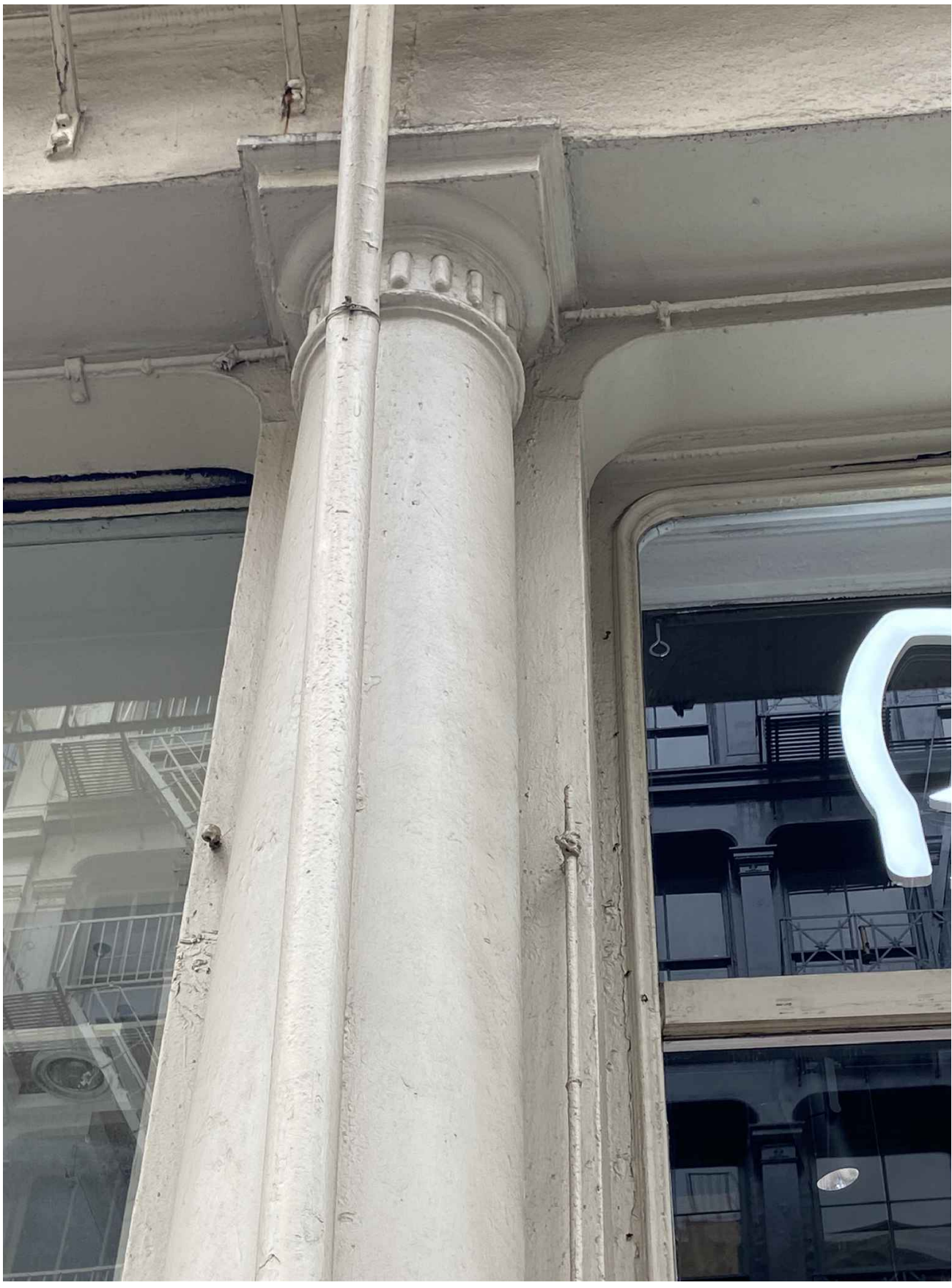
3 CAST IRON COLUMN SHAFT CLOSE UP A-901 SCALE: N.T.S.
