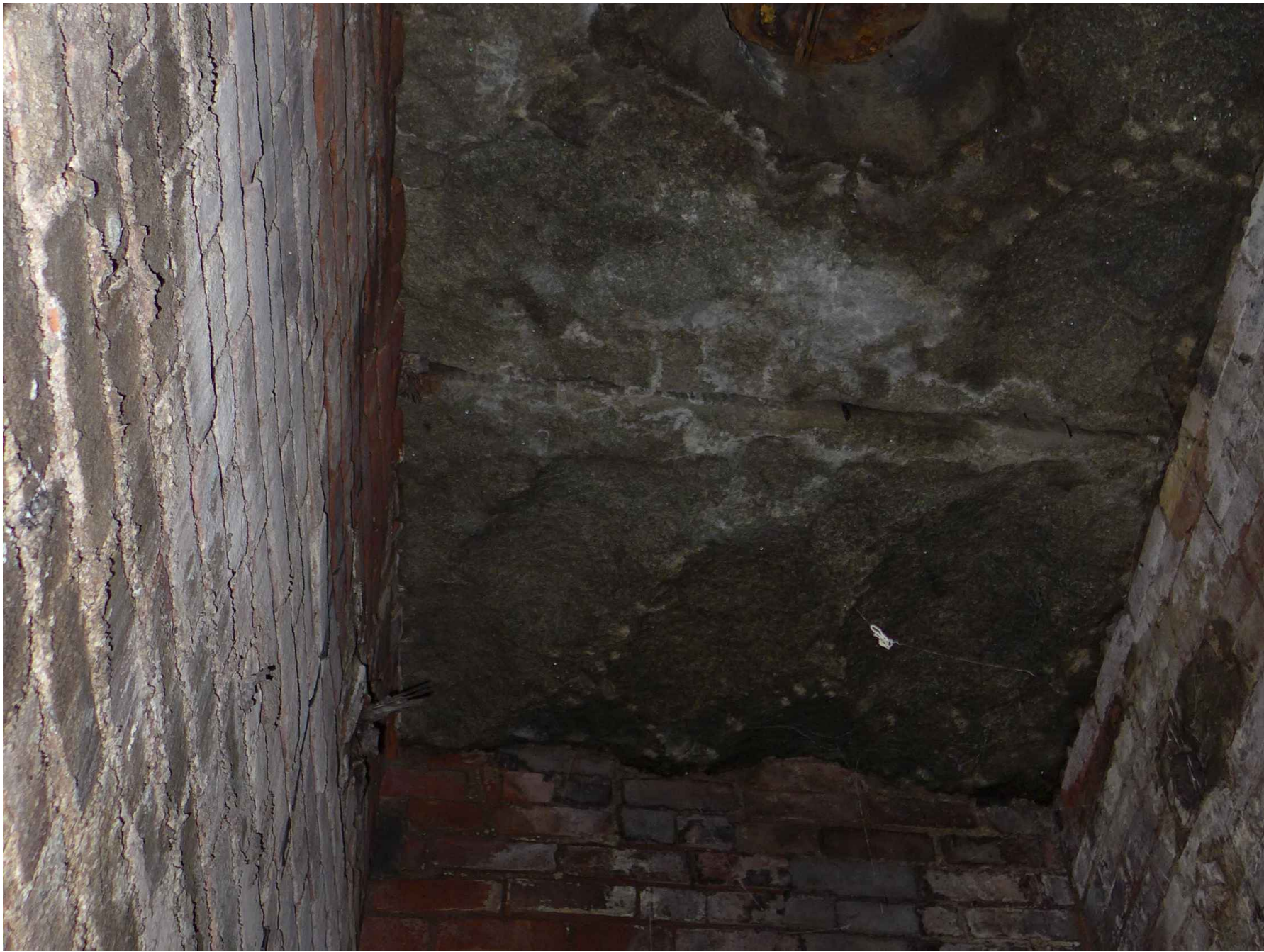
2 UNDERSIDE OF GRANITE ON SIDEWALK A-104 SCALE: N.T.S
