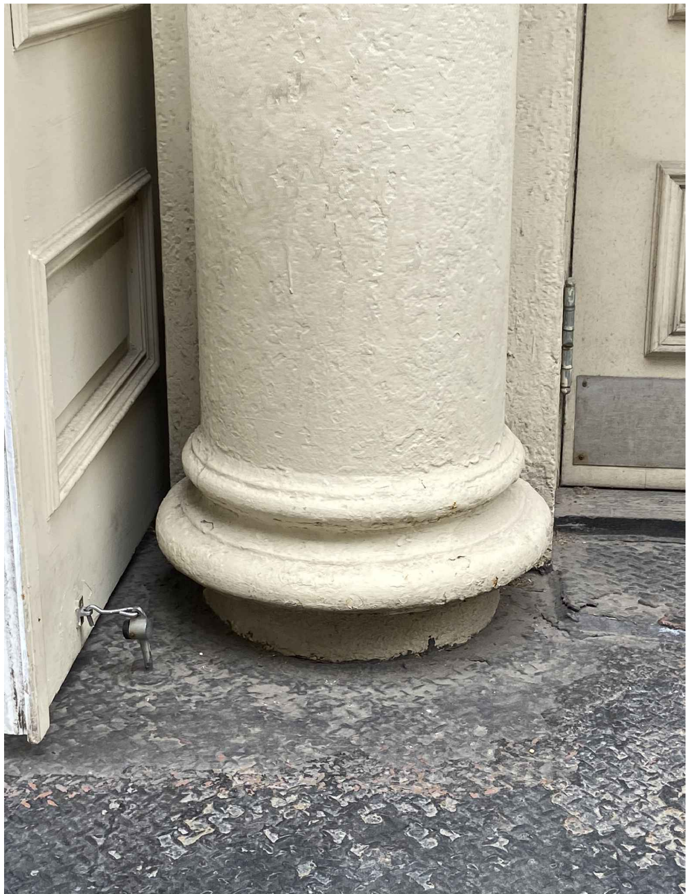
2 CAST IRON COLUMN 3 BASE CLOSE UP A-902 SCALE: N.T.S.
