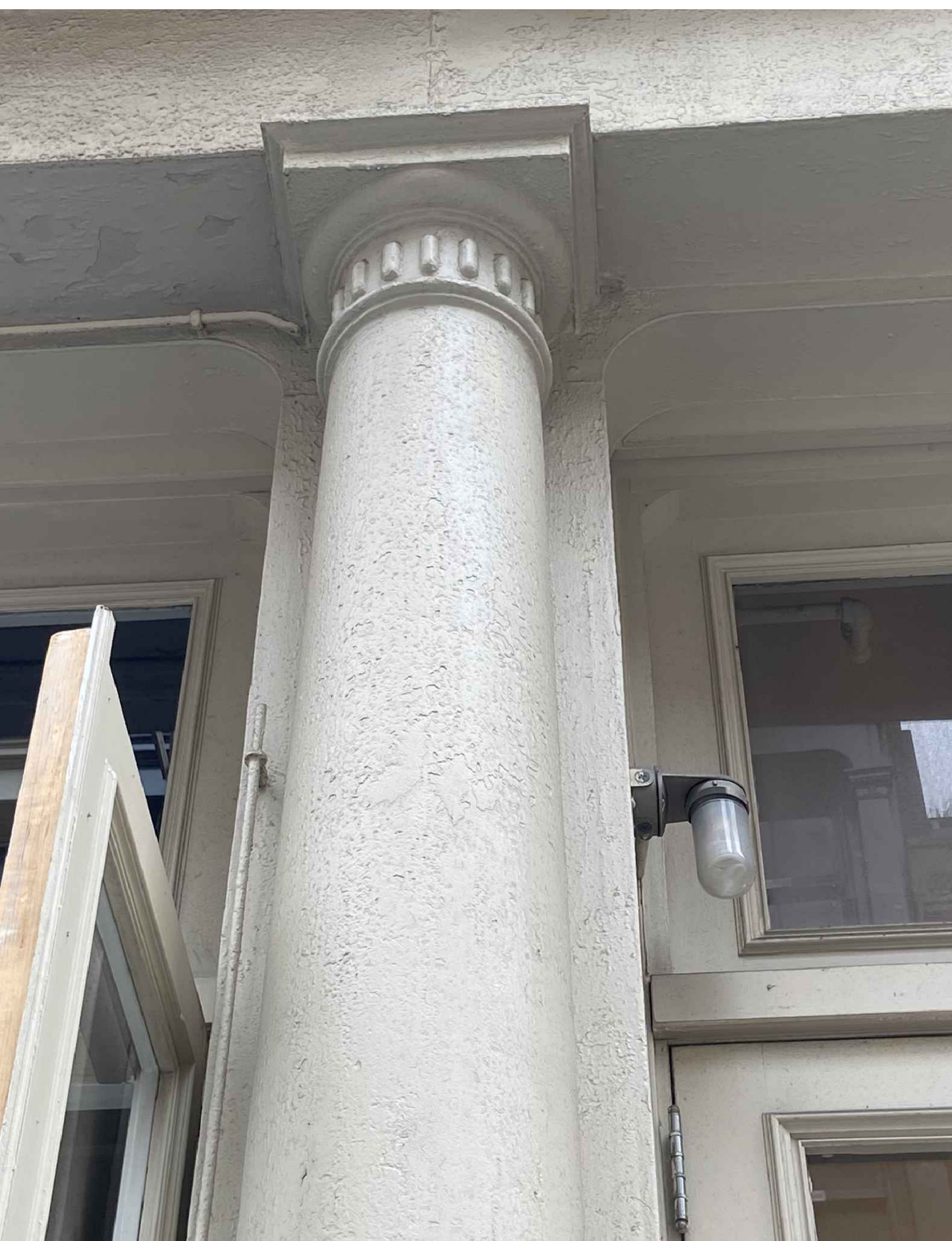
3 CAST IRON COLUMN 3 SHAFT CLOSE UP A-902 SCALE: N.T.S.
