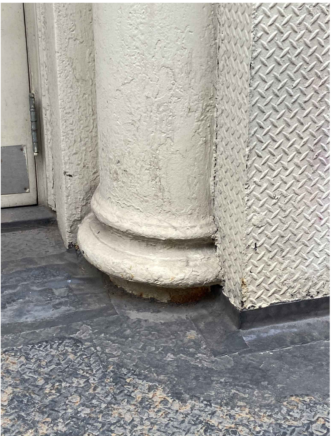
6 CAST IRON COLUMN 4 BASE CLOSE UP A-902 SCALE: N.T.S.
