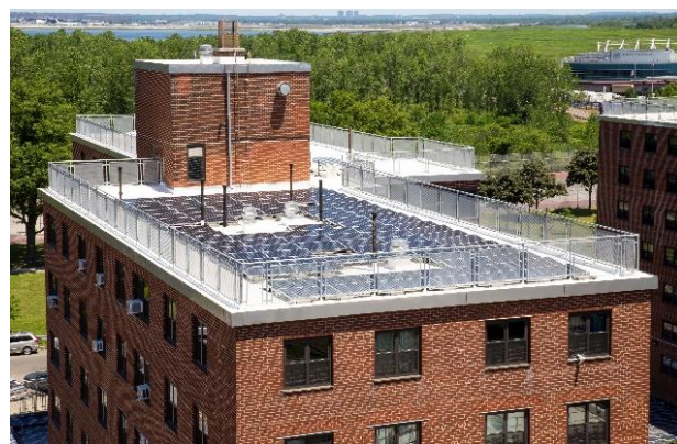
Отремонтирована крыша и система солнечных батарей на Ocean Bay (Bayside)
