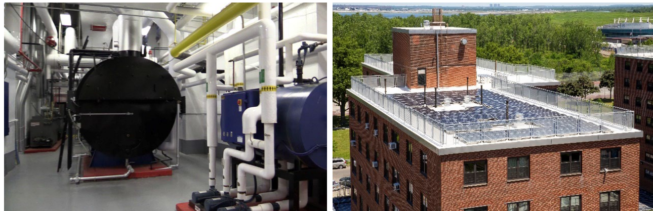
新安裝和翻修Ocean Bay (Bayside)住宅區的住宅樓設施
