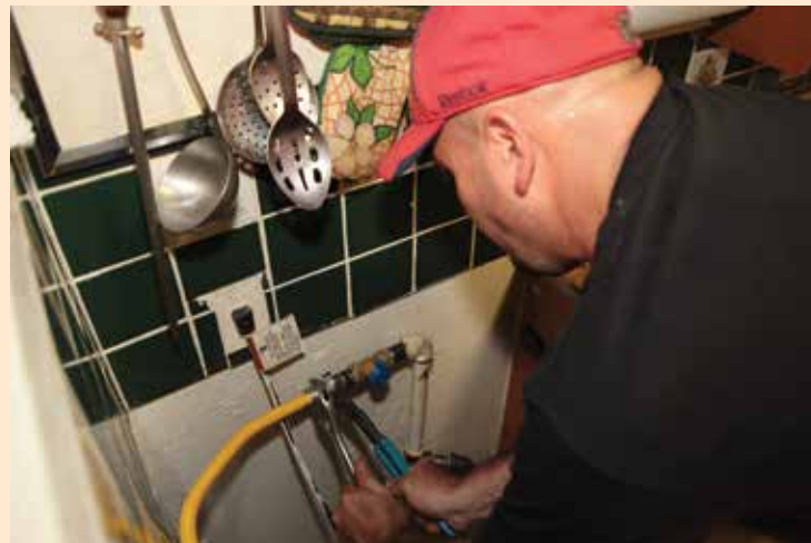
Un plomero de NYCHA verifica una línea de gas en la cocina de un residente para asegurarse de que no hay fugas.
