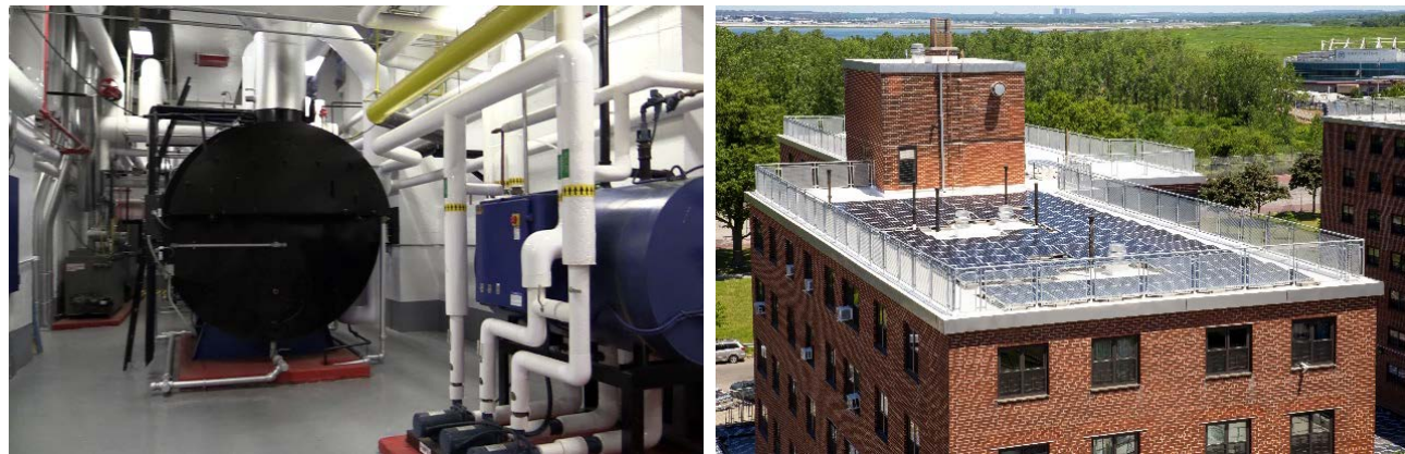
新安装和翻修Ocean Bay (Bayside) 住宅区的住宅楼设施
