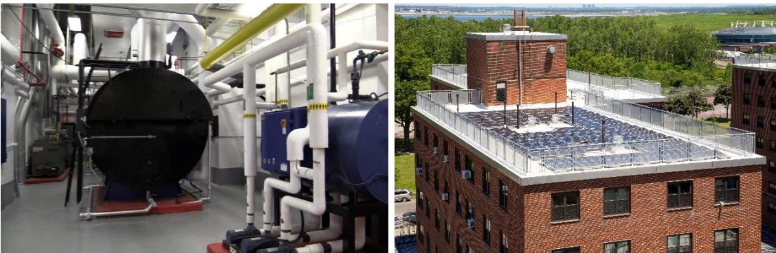
新安裝和翻修Ocean Bay (Bayside)住宅區的住宅樓設施
